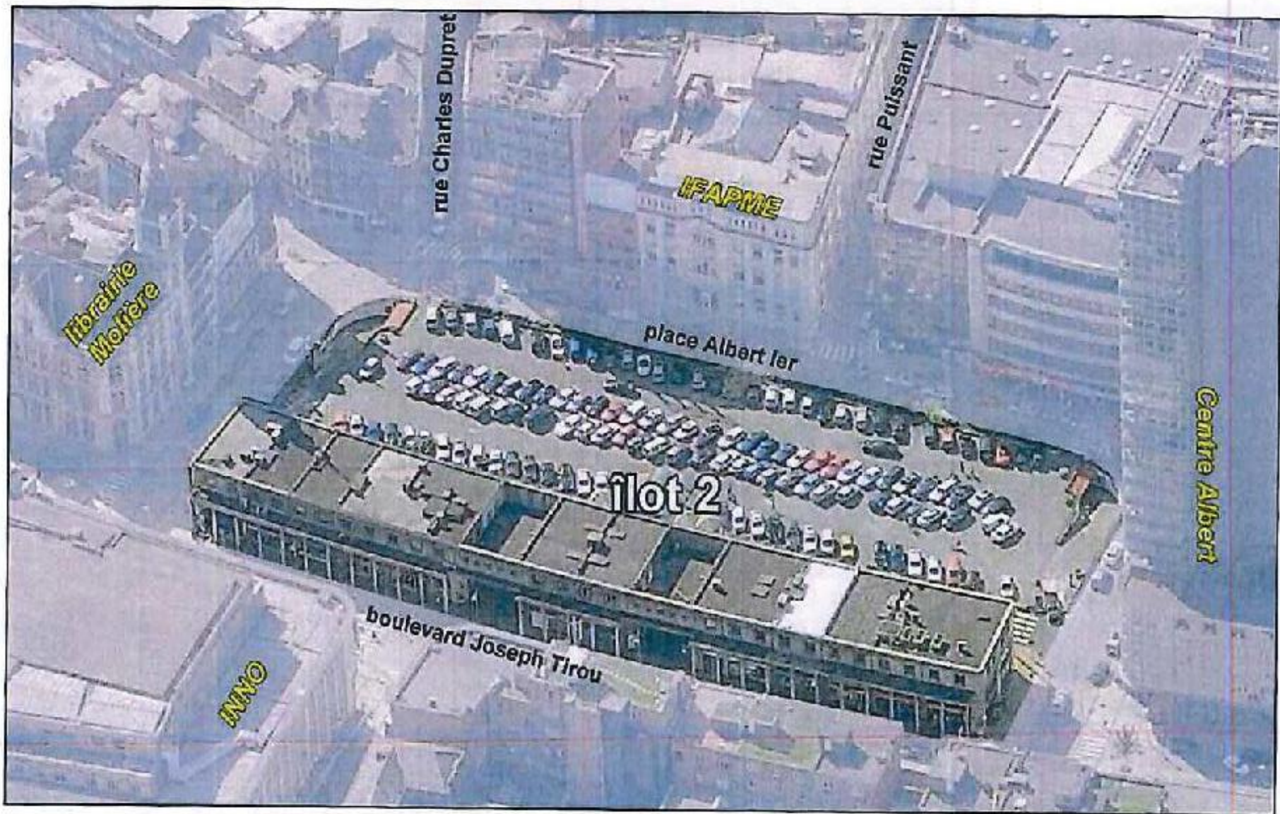
Figure 12 : Vue aérienne depuis le nord sur la place Albert I er (image Bing Maps, 2011)
