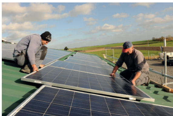
Installation de la centrale photovoltaïque
