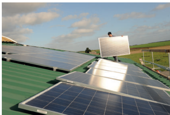
Installation de la centrale photovoltaïque
